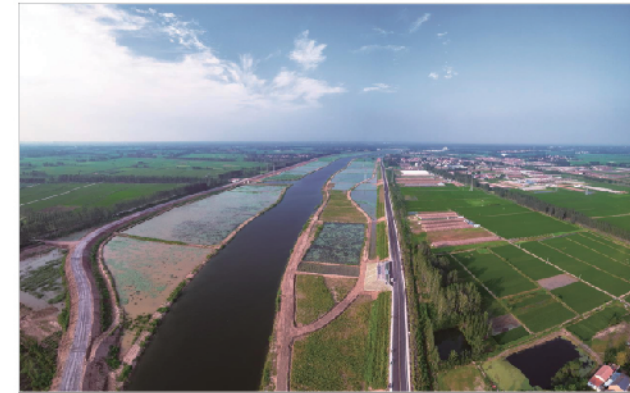
山东省鱼台县水系生态综合治理惠河南、北段--惠河两岸水利生态治理--荣获省优质工程奖
