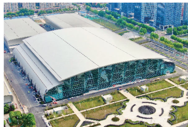
4综馆东北立面 (玻璃幕墙棱角分明、铝板幕墙美观大气,呈现钢柔之美)
