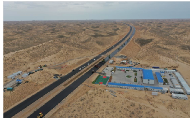
新疆S21阿勒泰至乌鲁木齐公路建设一期 (黄花沟至乌鲁木齐段) HW-4标段--地处沙漠腹地, 无水、无电、无人区施工--荣获省级优质工程奖
