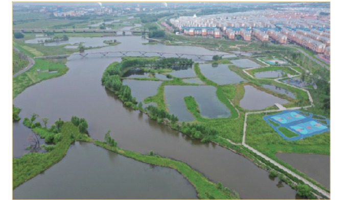
七台河市桃山湖生态环保水利综合治理项目-倭肯河流域治理-北方首个山水林田湖草治理项目, 荣获国家优质工程奖、鲁班奖。
