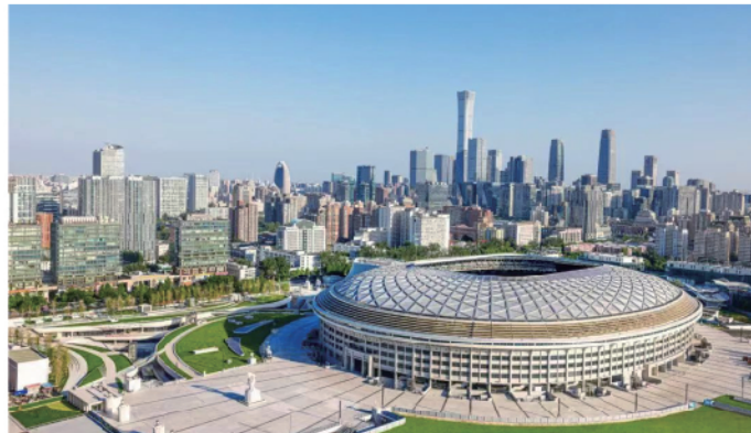
北京工人体育场北立面全景图
