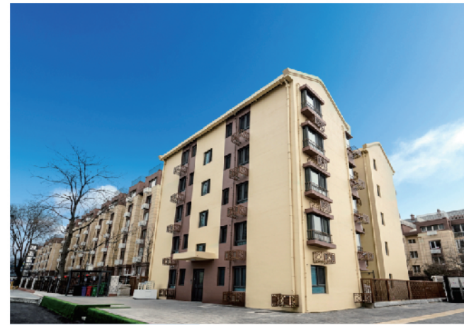
北京桦皮厂胡同8号楼改建项目
